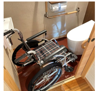
スライドドア・段差なし ドア内幅85cm・手すりあり
